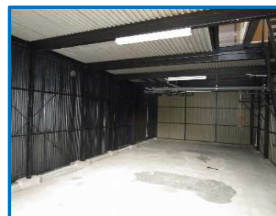
1階ガレージ部分
