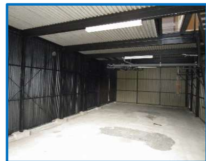
1階ガレージ部分
